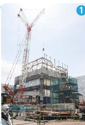
最大高さ約130mの超大型クレーンを使用したガレキ撤去作業の様子
