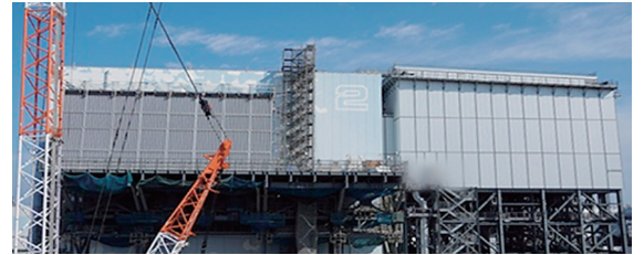
福島第一原子力発電所 2号機原子炉建屋
