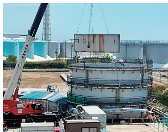
EエリアD1タンク 解体作業の様子 （2026年5月12日）
