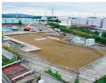
D1タンク解体後の Eエリアの様子 （2026年6月15日）
