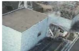
1号機の水素爆発に伴い開いた原子炉建屋上部側面のパネル
