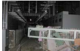
水素爆発直後の1号機原子炉建屋
