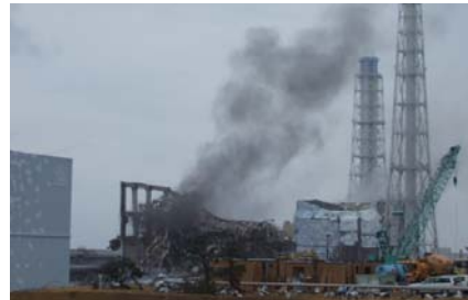
水素爆発後の3号機原子炉建屋
