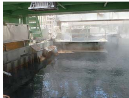
4号機の使用済燃料プールの様子 2011年6月29日撮影
