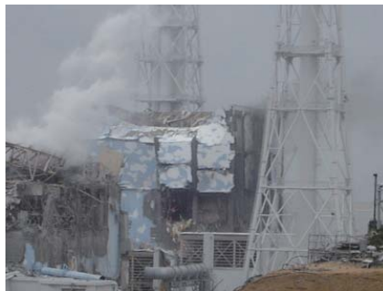
水素爆発後の4号機原子炉建屋
