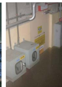
水没した電源室 (福島第一原子力発電所2号機)
