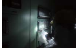
集めたバッテリーを計器等に接続 (1/2号機中央制御室)
