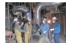
海水系ポンプモーターの交換作業の様子(後日撮影)
