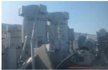
津波で機能を喪失した海水系ポンプ
