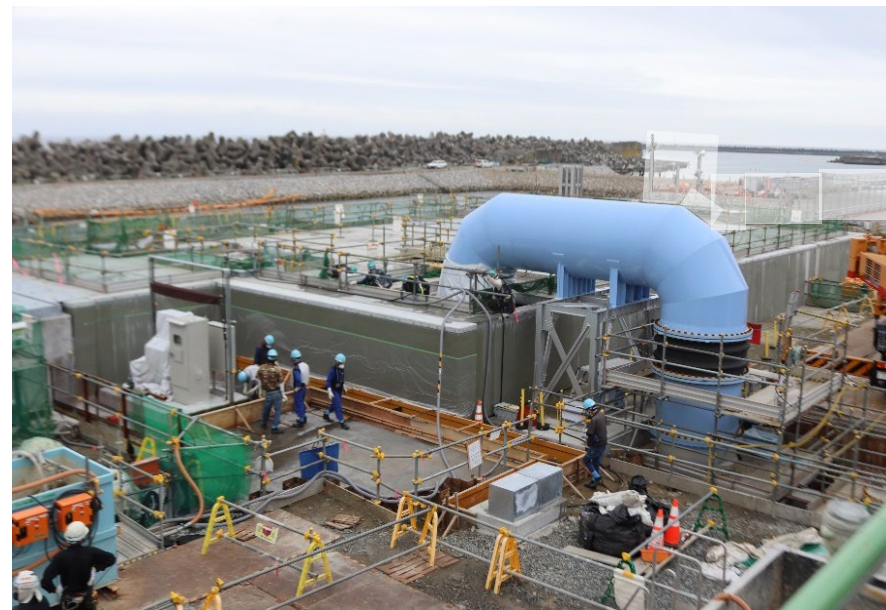
放水立坑（上流水槽）全景 [2023年6月23日撮影]
