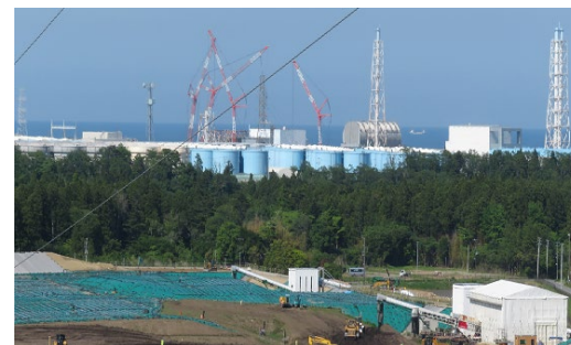
中間貯蔵施設内から見る福島第一原子力発電所
