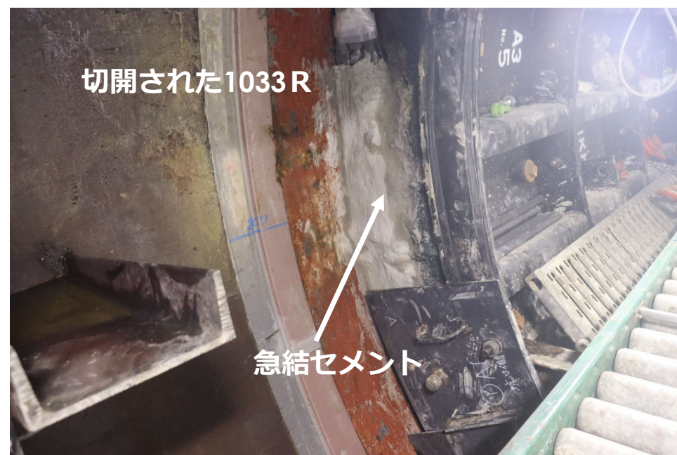
トンネル先端状況（止水工事の状況）
