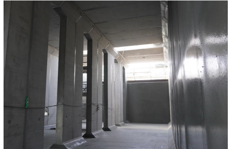
内部の状況（防水塗装完了）
