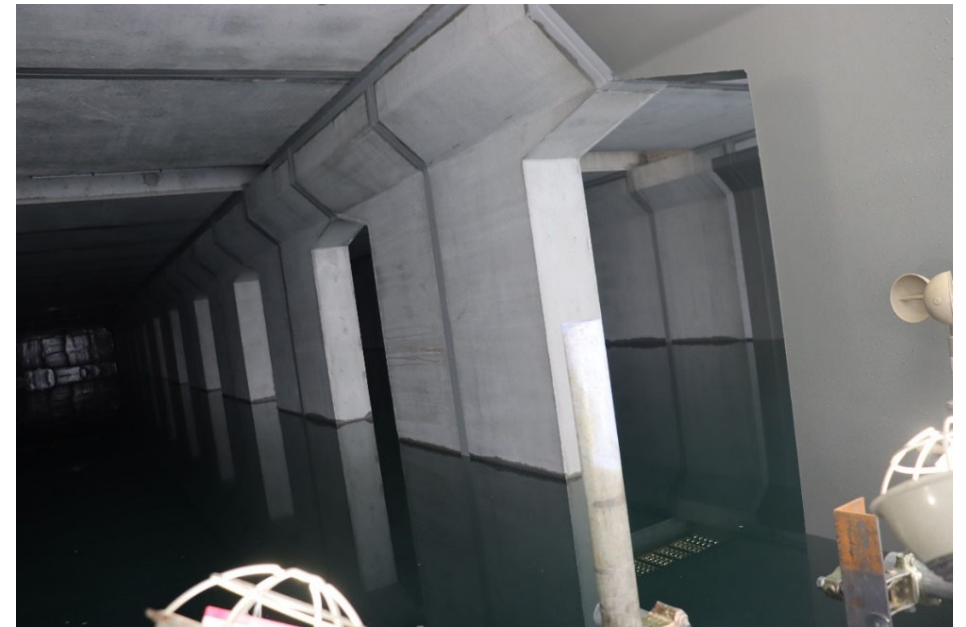
内部の状況（注水完了）
