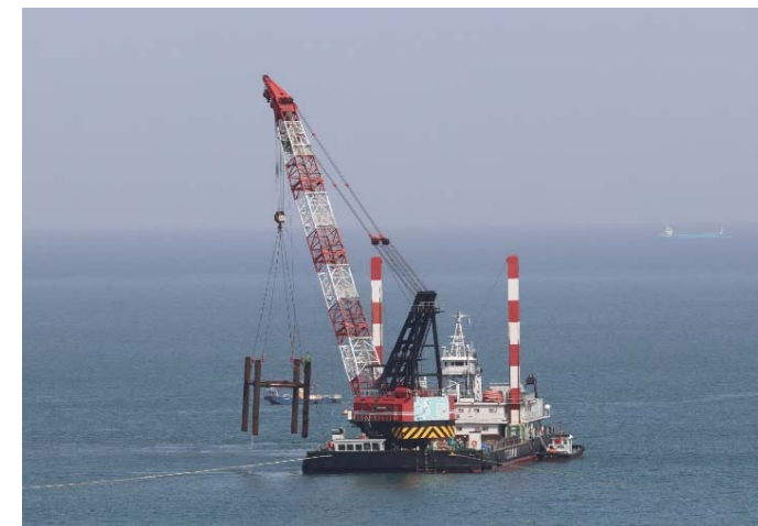
測量櫓（下段）撤去状況
