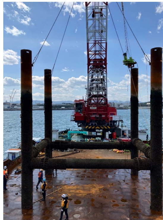
測量櫓（上段）撤去状況
