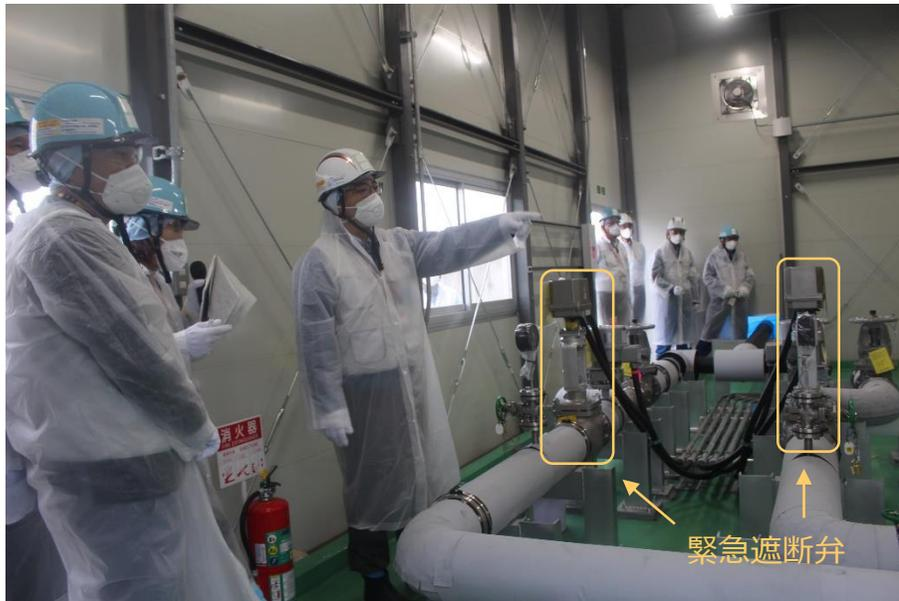
国際原子力機関（IAEA）による緊急遮断弁の確認
