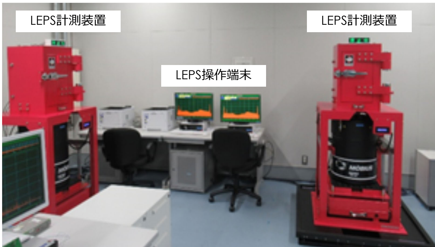
LEPS設置状況 (化学分析棟計測室内)
