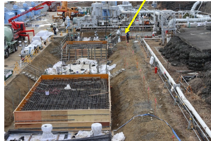
海水移送配管基礎の構築状況
