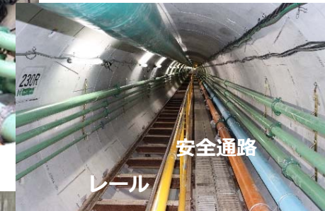
トンネル内部安全設備の整備状況
