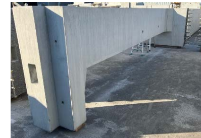
上流水槽隔壁
