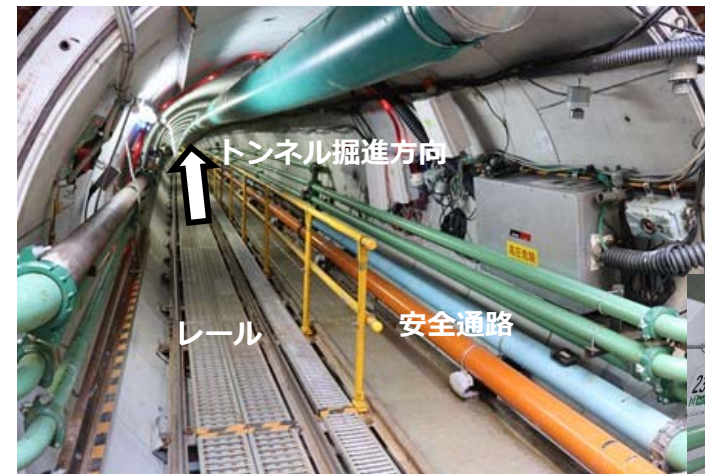
トンネル内部安全設備の整備状況
