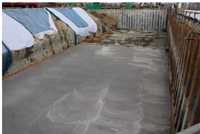
均しコンクリート打設の状況
