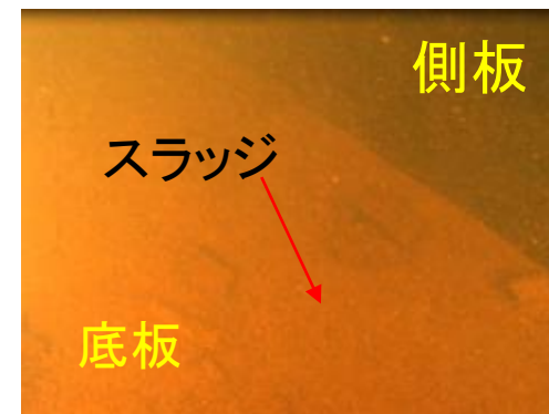
タンク底部の状況 (ROV内面点検時に撮影)
