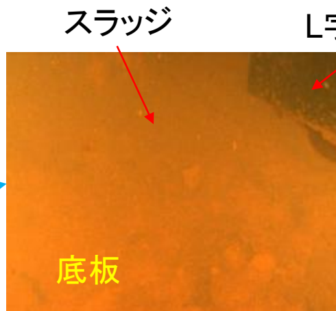
タンク底部の状況 (ROV内面点検時に撮影)
