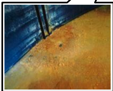
スラッジ回収前
