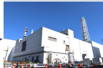
高温焼却炉建屋
