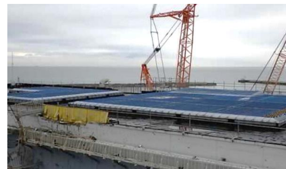
3号機タービン建屋 損傷部補修
