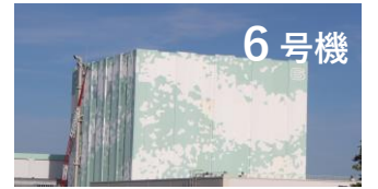
燃料取り出し実施中
