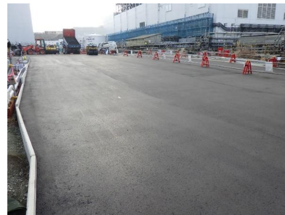
4号機原子炉建屋山側 敷地舗装
