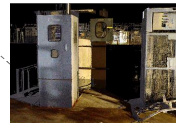
北側シェル壁点群
