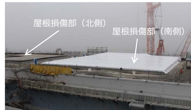
3号機タービン建屋・屋根状況 【流入防止堰・雨水カバー (南側) 設置完了】 〔西側から撮影〕
