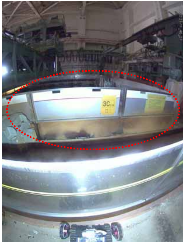
2012年2月28日 福島第一原子力発電所2号機 原子炉建屋5階 オペレーティングフロア ロボット（クインズ2）による調査結果
