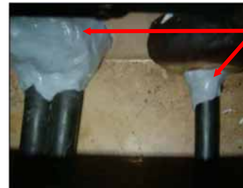
漏水防止措置 (イメージ)
