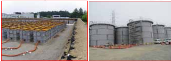
淡水用、RO濃縮水タンク
