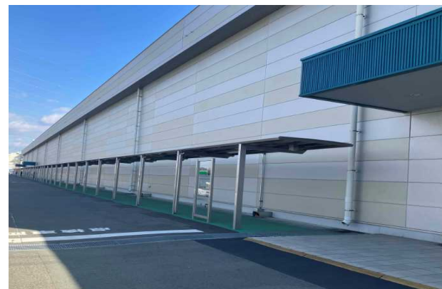
協力企業棟脇 安全通路・屋根の製作
