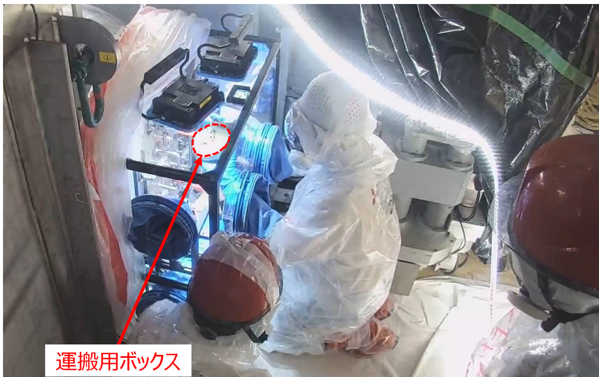
エンクロージャ側面ハッチから運搬用ボックスを取り出す様子
