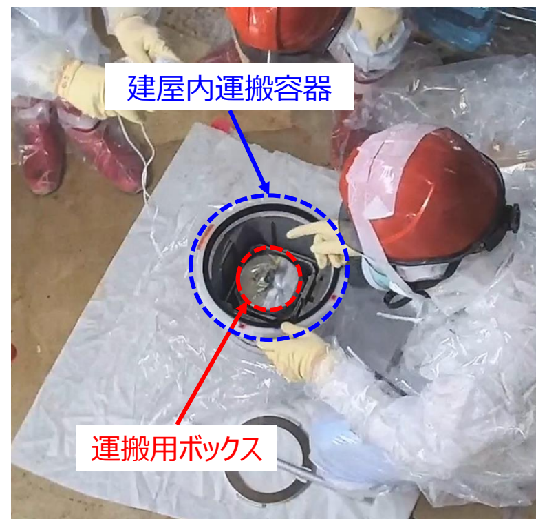
運搬用ボックスを建屋内運搬容器へ収納する様子
