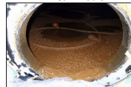
側板マンホールから内部撮影
