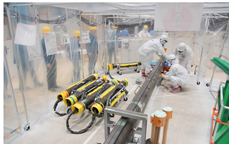
押し込みパイプの訓練状況
