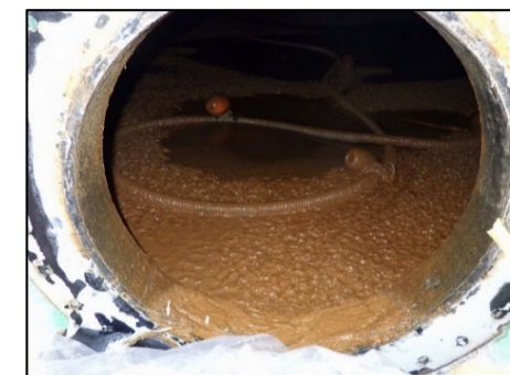
側板マンホールから内部撮影
