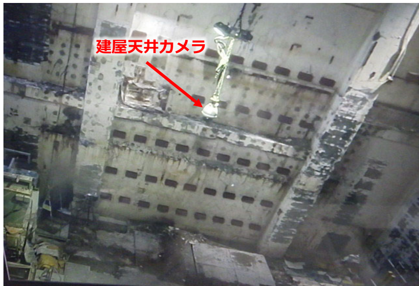
作業前 (撮影日:2024年11月22日)
