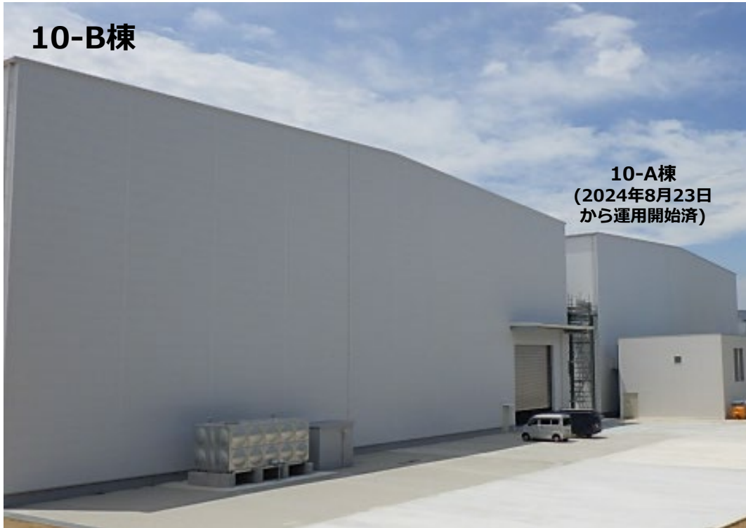
図1.固体廃棄物貯蔵庫第10棟の外観 (2024年7月29日撮影)
