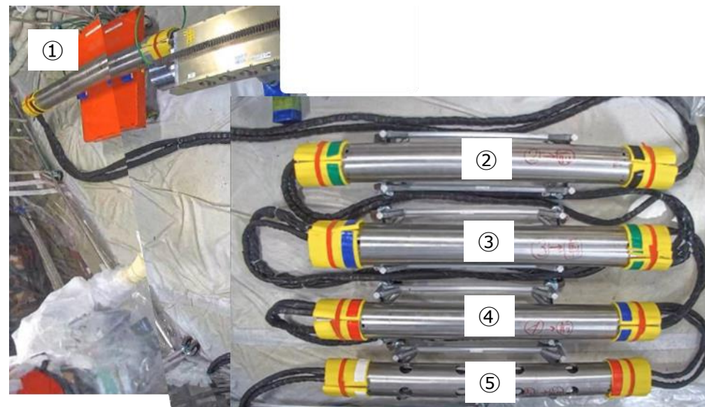
押し込みパイプの復旧作業の完了 撮影日：2024年9月8日
