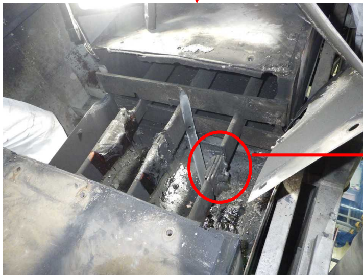
6号機タービン建屋地下1階 ダクト内①
