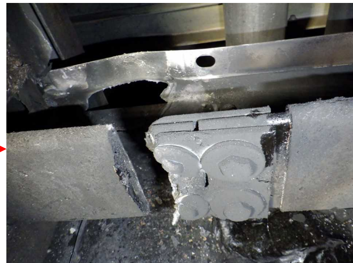
6号機タービン建屋地下1階 ダクト内②
