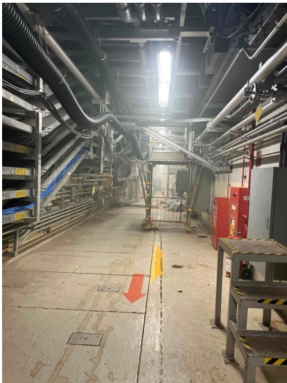
6号機タービン建屋地下1階 写真
