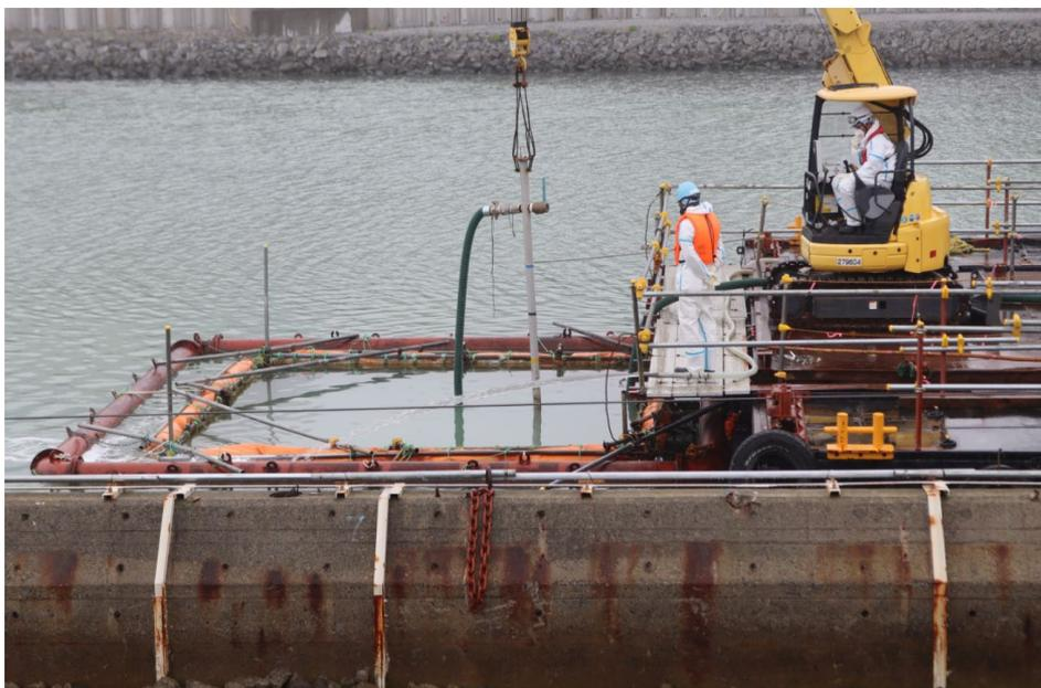
図2.海底再被覆工事(2層目の覆土施工)の状況
