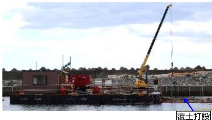
図5.ユニフロート台船による
