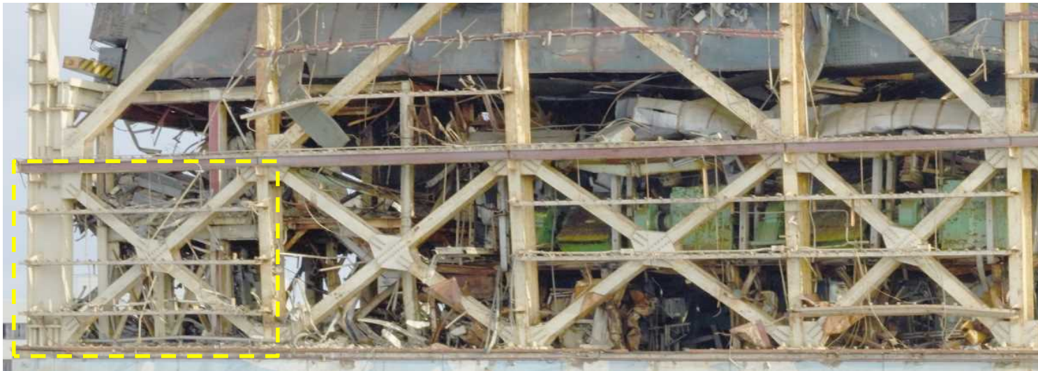
撤去対象（黄色枠部分のはみ出しガレキを撤去）
