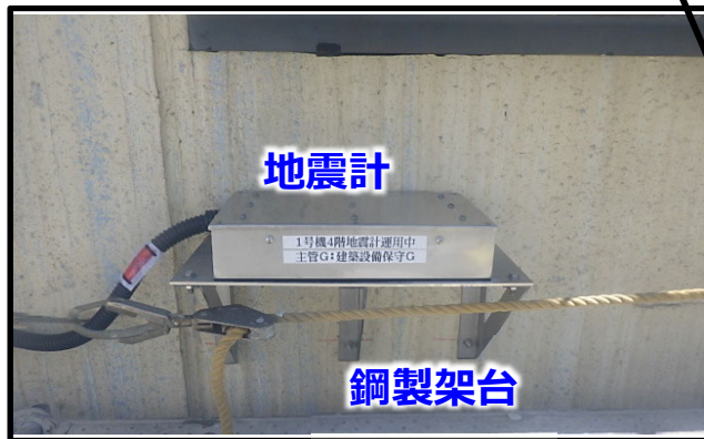
1号機原子炉建屋 4階フロア付近西側外壁
