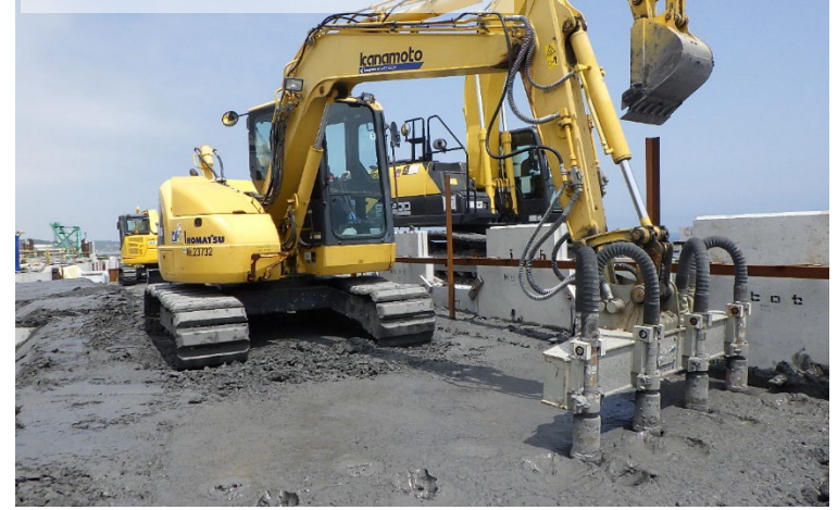
アッシュクリート打設状況
