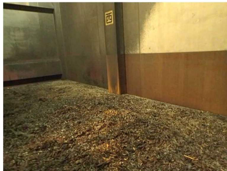
廃棄物貯留ピット内の状況②（3月7日撮影）
