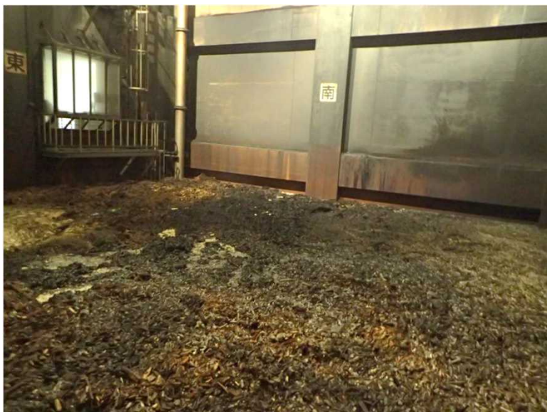
廃棄物貯留ピット内の状況①（3月7日撮影）
