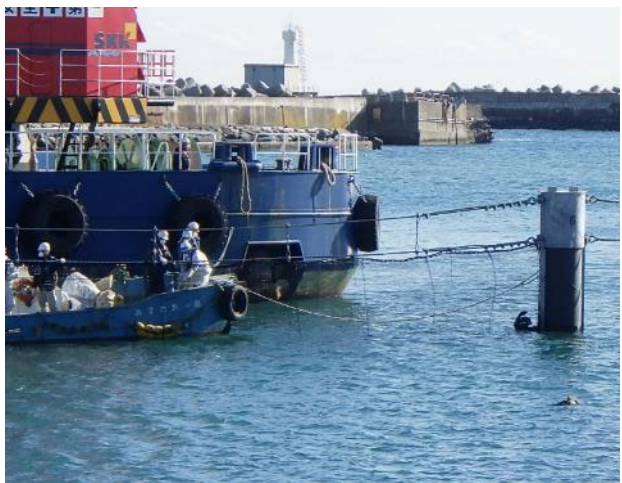
図6.作業員が海上で高耐久網を設置している状況 (2024年1月10日撮影)
