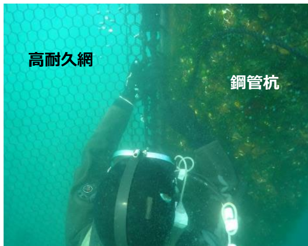
図7.作業員が水中で高耐久網を鋼管杭に 設置している状況 (2024年1月13日撮影)
