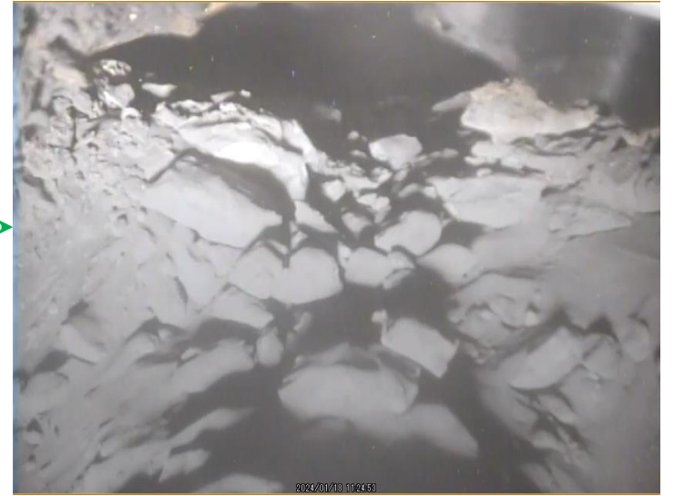
低圧水施工後 X-6ペネ上部（撮影日：1/18）
