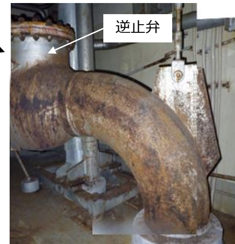
既設CUW配管
