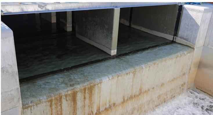
海水で希釈したALPS処理水が上流水槽から下流水槽に越流している様子
