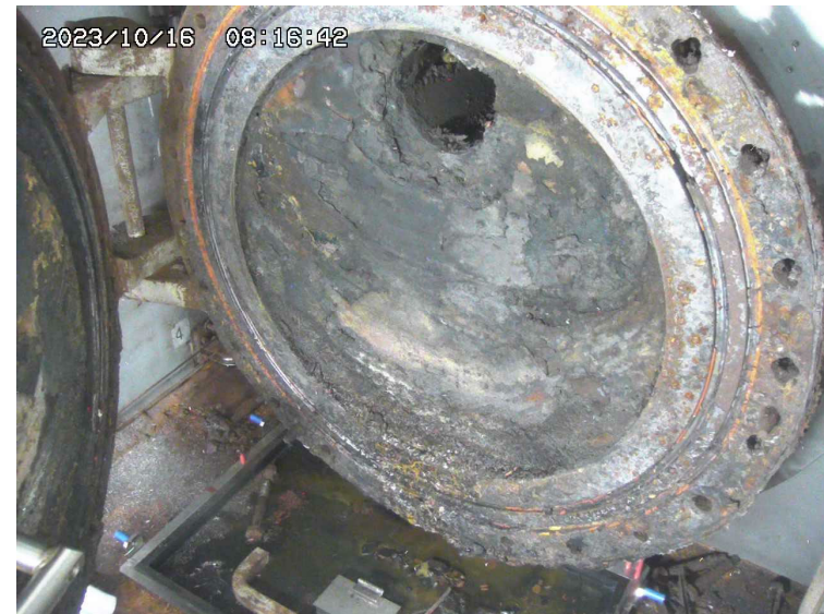
図2.X-6ペネハッチの開放作業中の状況
