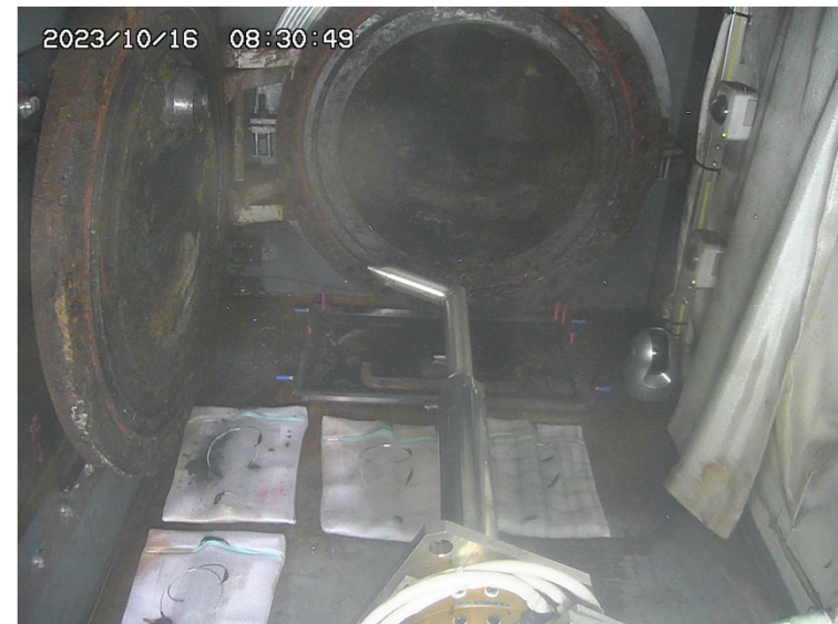
図4.X-6ペネハッチの開放後の状況② (X-6ペネを正面から見た状況 左がハッチ(蓋))
