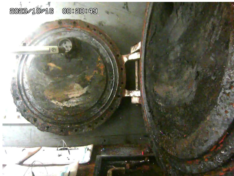
図3.X-6ペネハッチの開放後の状況① (X-6ペネを右側から見た状況 左がハッチ(蓋))
