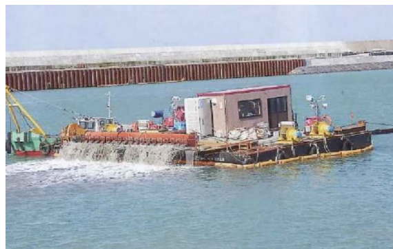
図3.ユニフロート台船による覆砂工事
