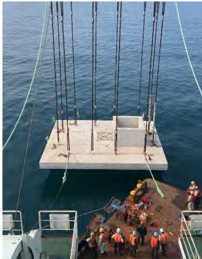
放水口ケーソン上蓋設置作業の様子①
