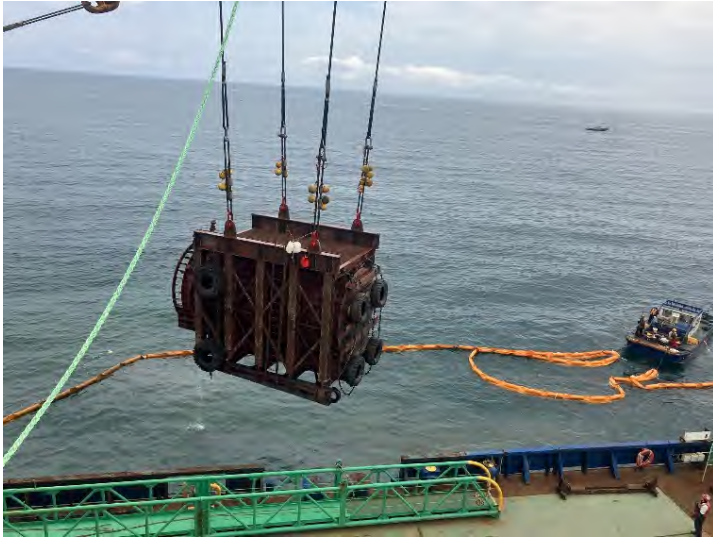
到達管の撤去作業の様子①
