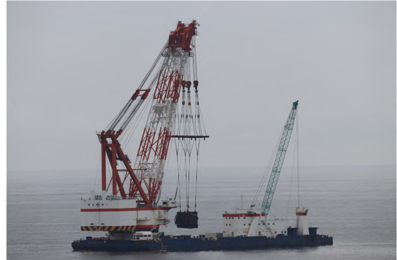
到達管の撤去作業の様子②
