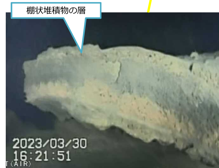
写真3. ペDESTAL外棚状堆積物断面
