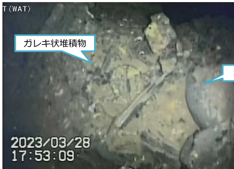
写真2.ペDESTAL内開口付近堆積物
