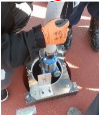
配管内アクセス装置挿入(3階)
