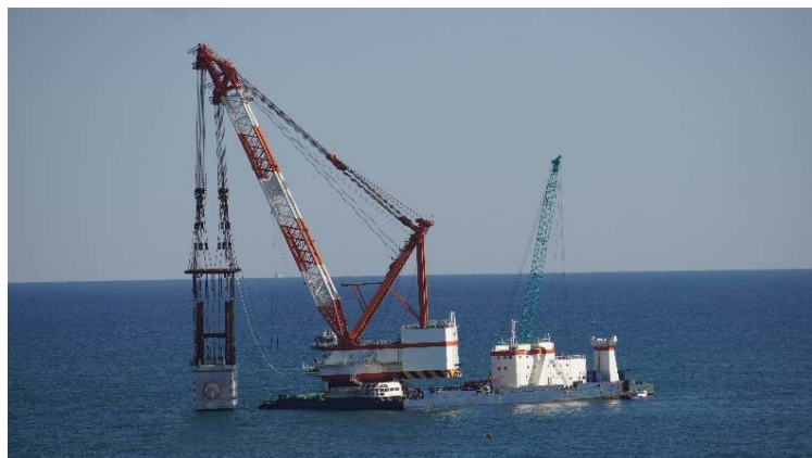
放水口ケーソンの据付工事の様子②
