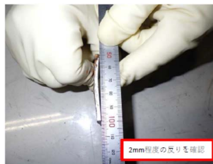
ボルト及び座金等 締結部材の状態
