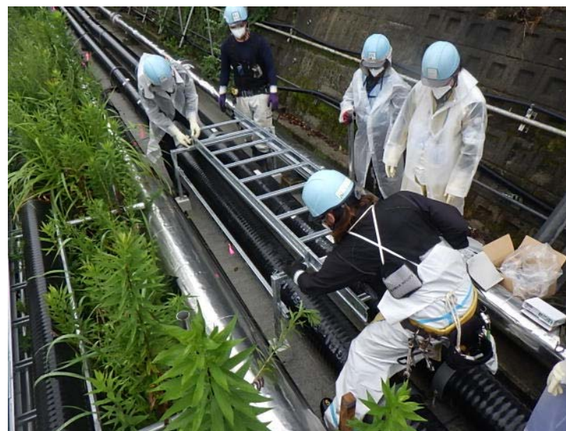
移送配管サポート設置の状況
