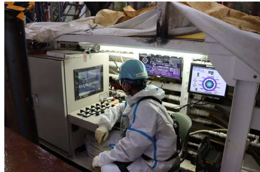
シールドマシン掘進の作業状況②
