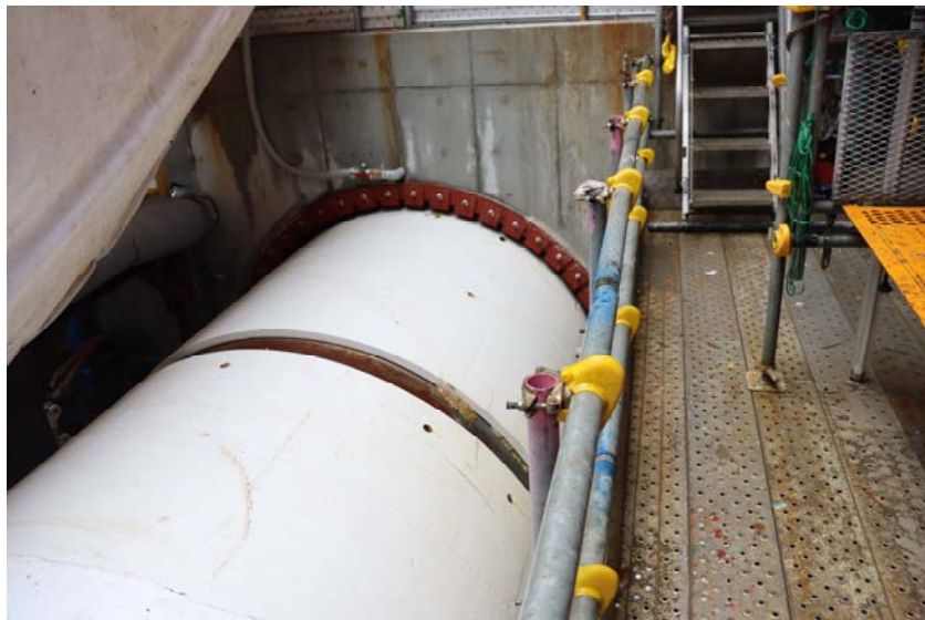
シールドマシン掘進作業の状況①
