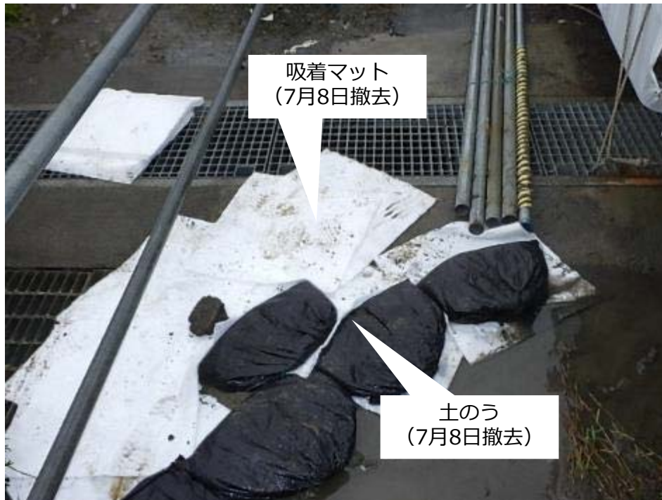
漏洩した油の状況
