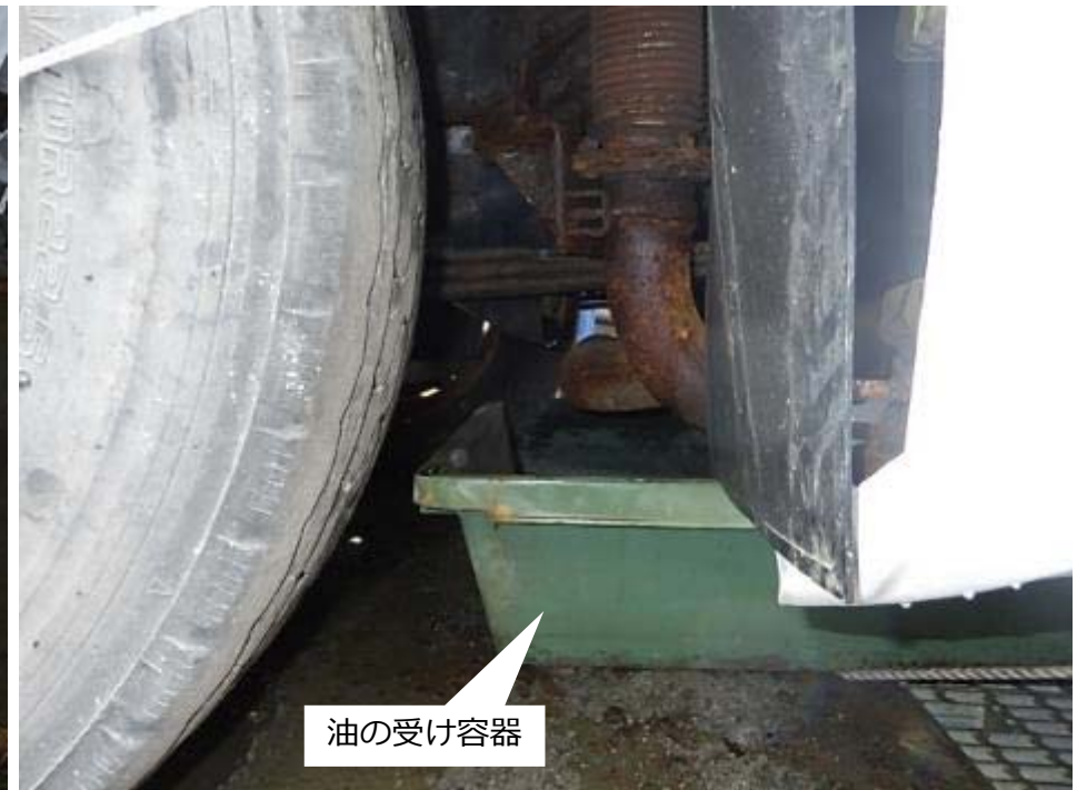
トレーラー下部へ受け容器を設置
