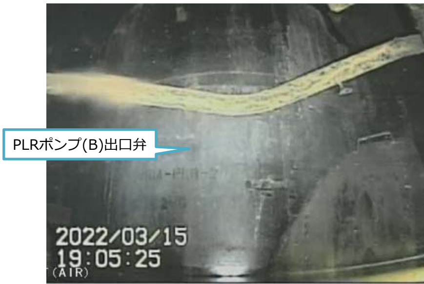
写真1. PLRポンプ(B)出口弁付近の状況
