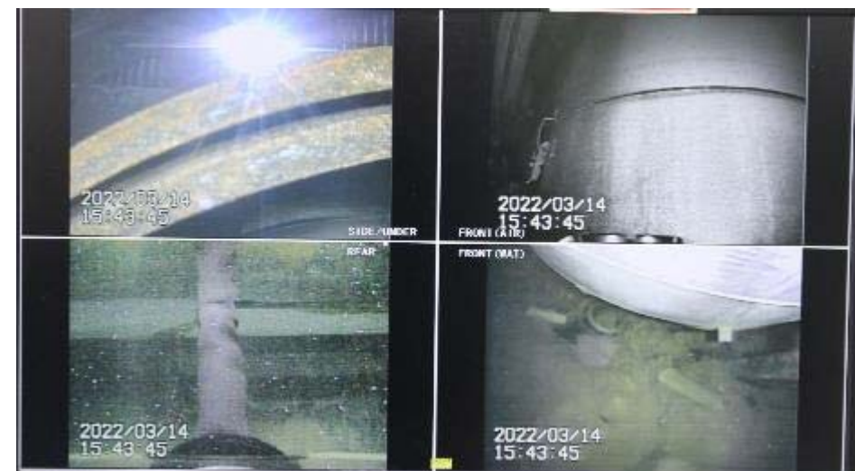
写真4.吊り下ろし地点での状況
