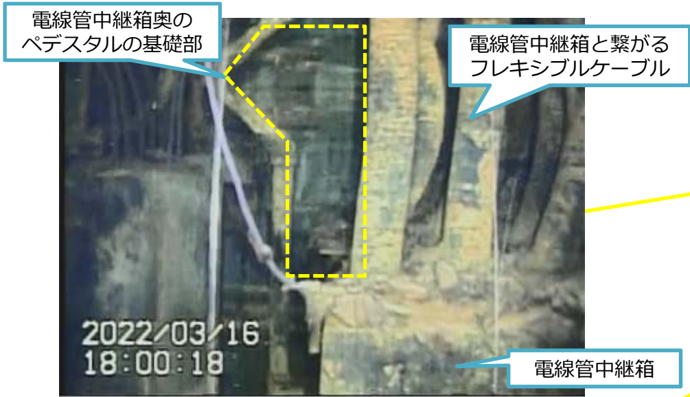
写真1.ペDESTAL基礎部付近の状況①
