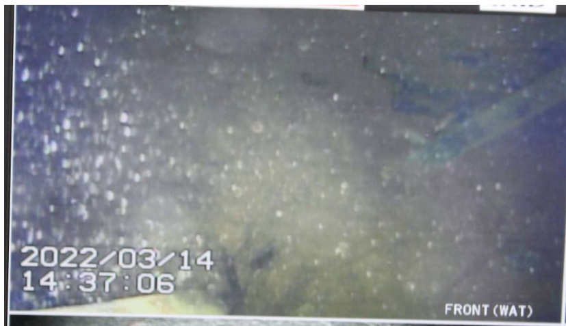
写真3.PCV底部水面への着水時の状況
