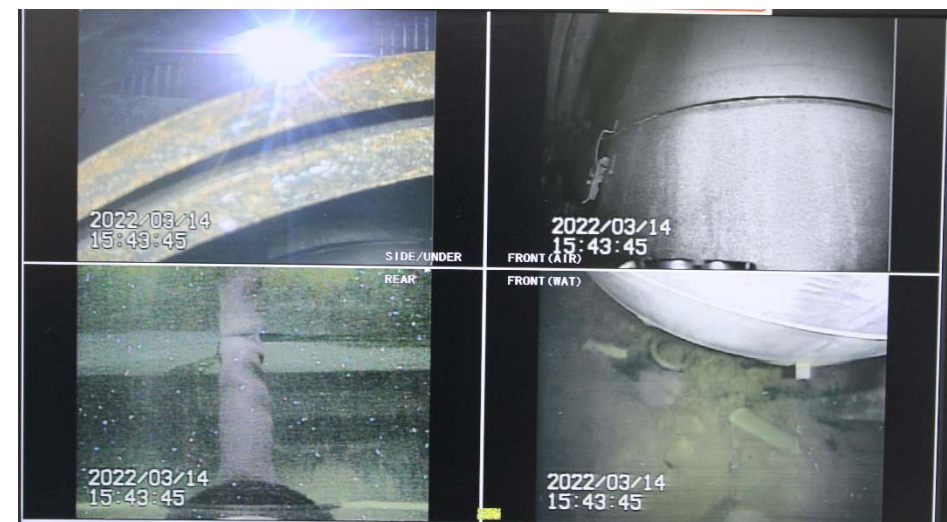
写真4.吊り下ろし地点での状況
