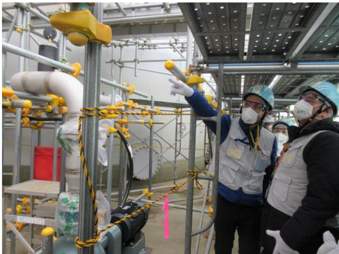
K 4 タンクエリア
