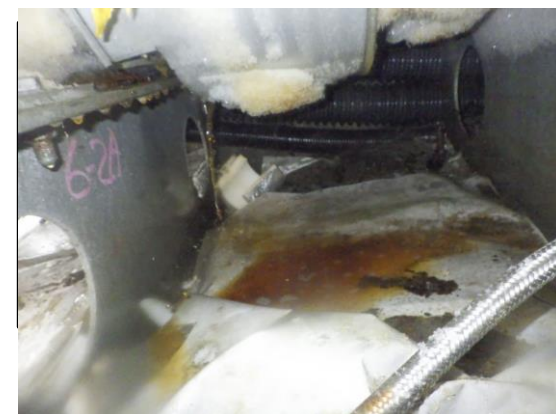
漏えい箇所（直下）
