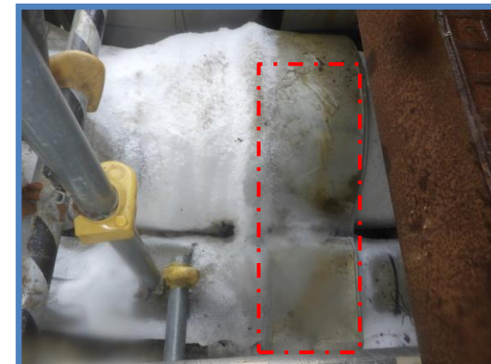
漏えい箇所（真上より）
