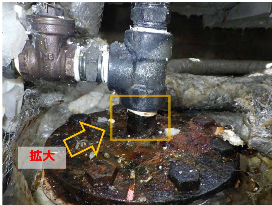
【50-5Tの凍結管頭部写真】
