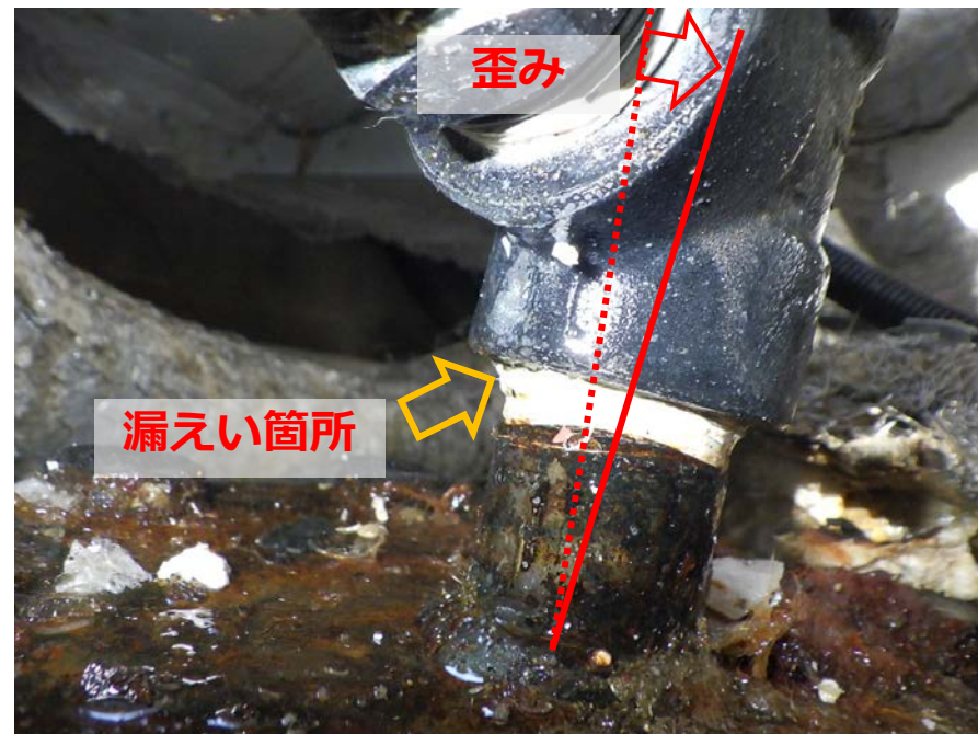
【継手部拡大写真】
